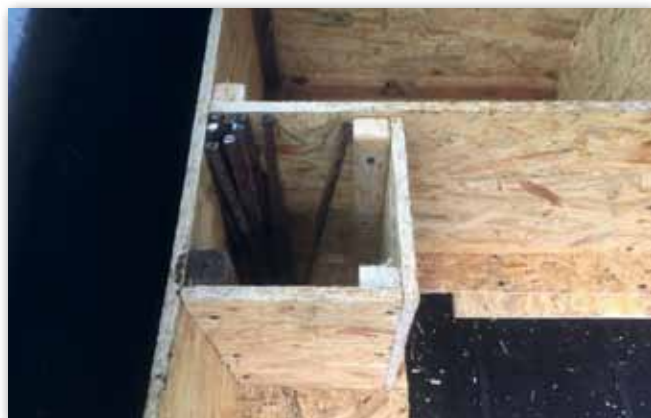
Fot. 10. Zabudowa na rurki i pręty
