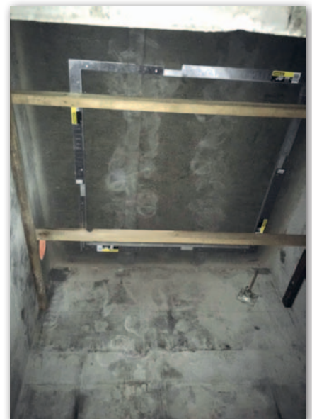
Fot. 2. Rama pomiarowa powieszona w nadszymbiu
