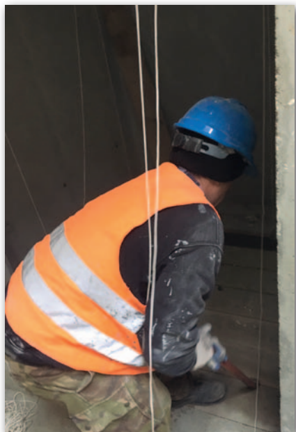
Fot. 3. Pracownik budowy demontuje zabudowę szybu windowego
