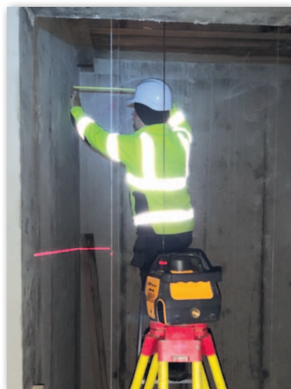
Fot. 8. Pomiar odległości ściany od pionu
