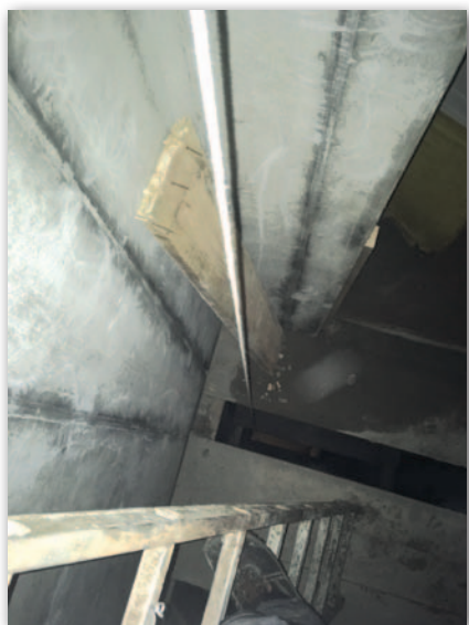
Fot. 4. Opuszczanie pionu przez zdemonstrowane deski zabudowy tymczasowego podestu w szybie
